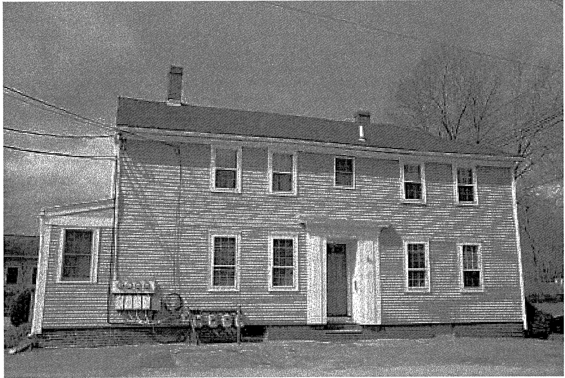
Photo 24) 39 Franklin St. façade
