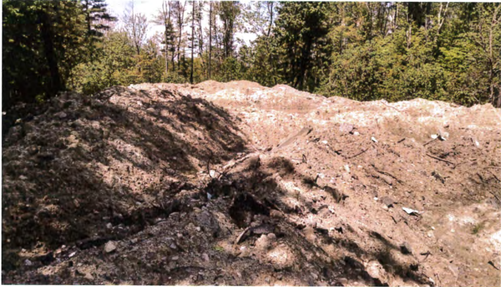
5. Surplus fill pile
