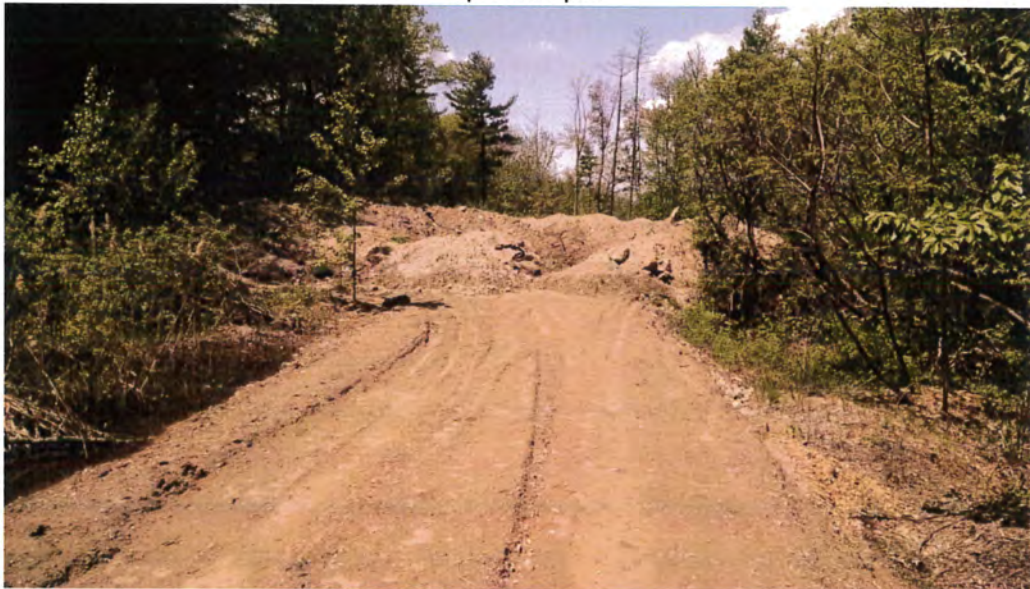
6. Surplus fill pile
